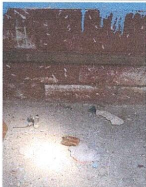
Foto 1: Mejoramiento de piso frente a sanitarios y dirección
