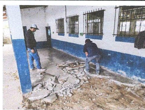
Foto 4: Mejoramiento de piso de corredor frente a aulas de módulo 3
